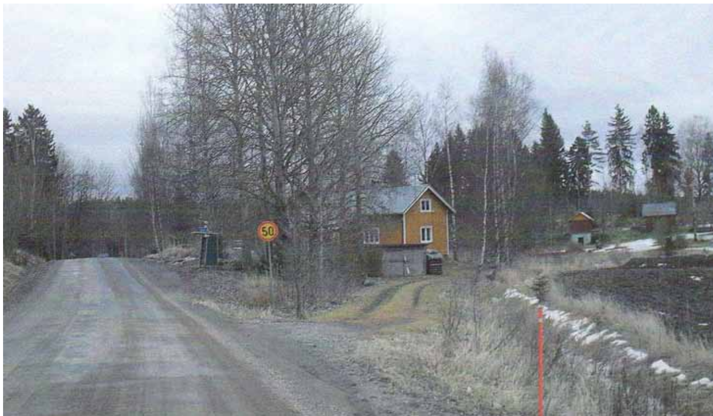
Lähtenmäen talossa aloitti Nuutajärven Osuuskauppa vuonna 1938. Pädystä puuttuu silloinen sisäänmeno-ovi. Kuva Risto Vuori.
